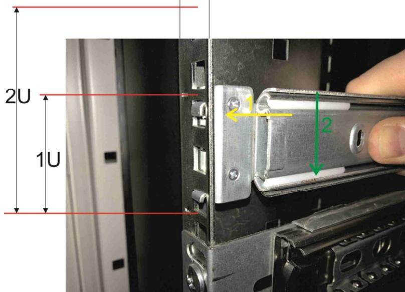
Nachdem Sie alle 4 Befestigungen eingerastet haben, können Sie diese noch mit einer Schraube in den mittleren Löchern sichern.
